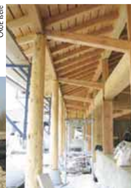
L'ossature des bâtiments est en douglas, bois de la commune.
