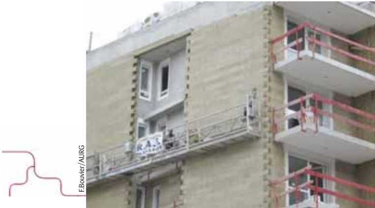
La construction d'un bâtiment avec isolation par l'extérieur, à Grenoble.
