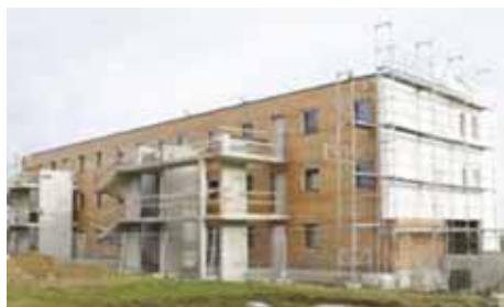
Construction d'un immeuble d'habitat collectif.
